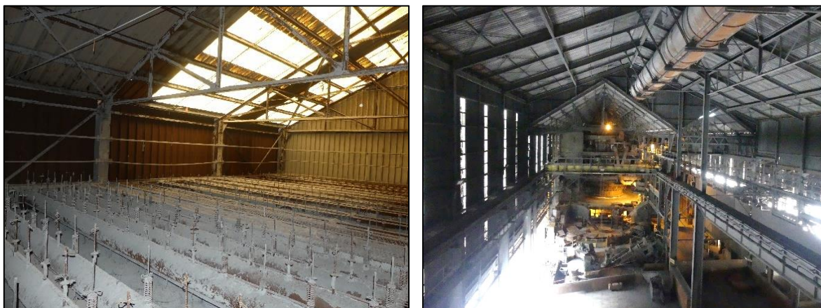
Figure 12 : Intérieur du filtre 1 et du bâtiment central, M. GARRIONE© EODD, 2023
