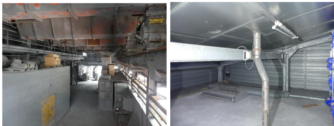
Figure 13 : Bâtiment central et combles du bâtiment administratif, M. GARRIONE© EODD, 2023
