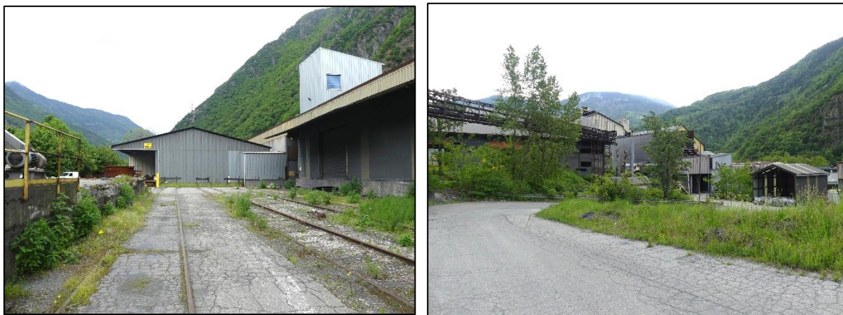
Figure 9 : Bâtiments et zones semi-ouvertes du site, M. GARRIONE© EODD, 2023.
